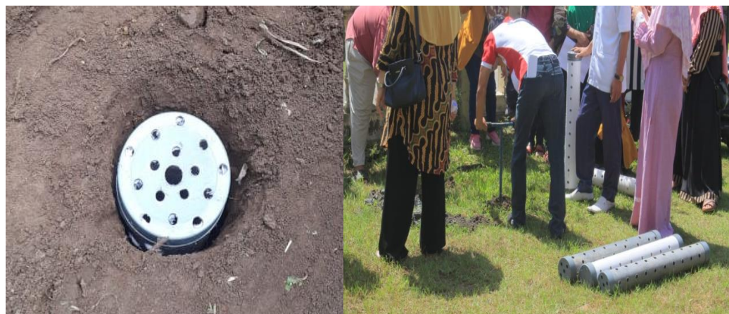
Gambar 3. Proses pembuatan lubang biopori
